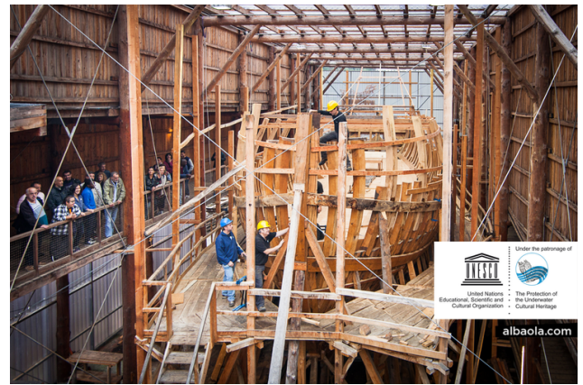
Le chantier-musée d'Albaola
